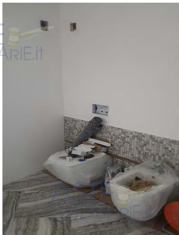
Vista locali bagno – rifacimento totale impianti
