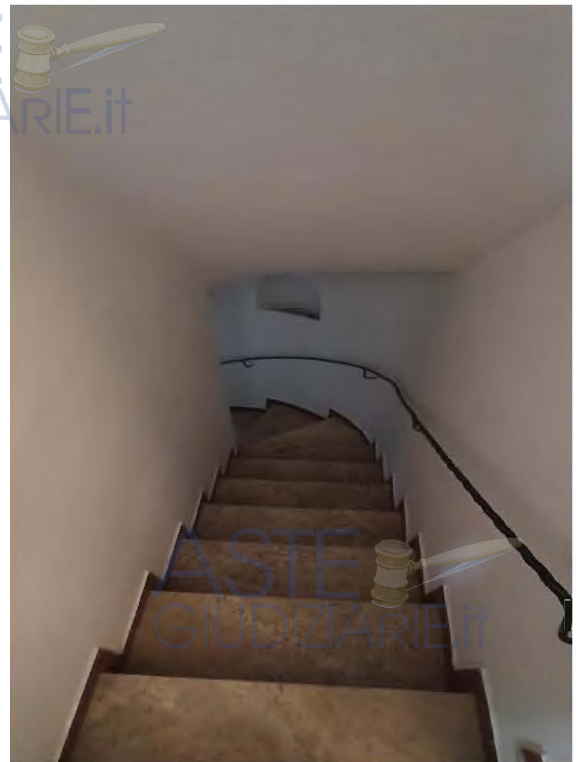
Vista scale di accesso al piano seminterrato
