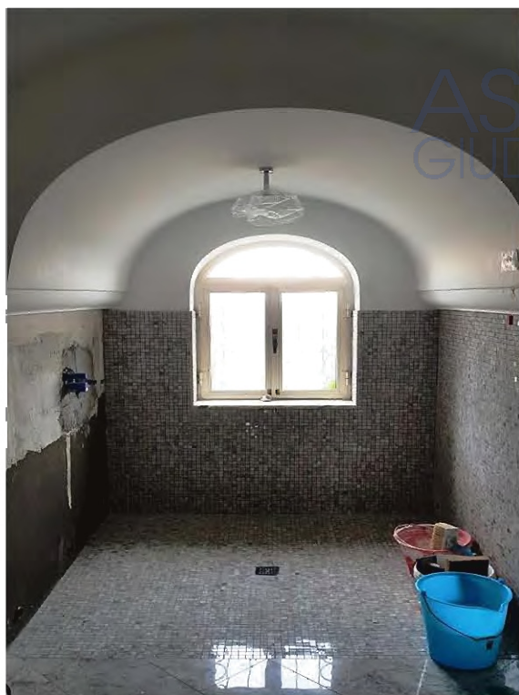
Vista locali bagno – rifacimento totale impianti
