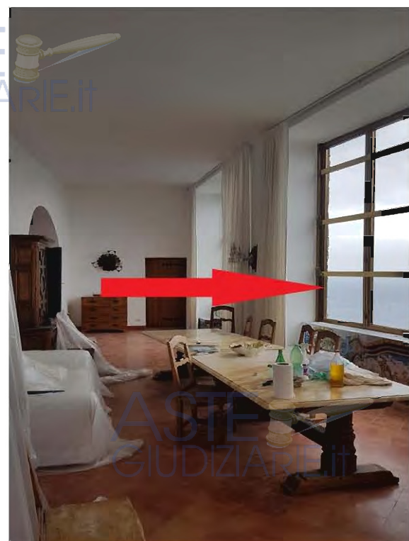
Vista infissi sostituiti nel corso dei sopralluoghi
