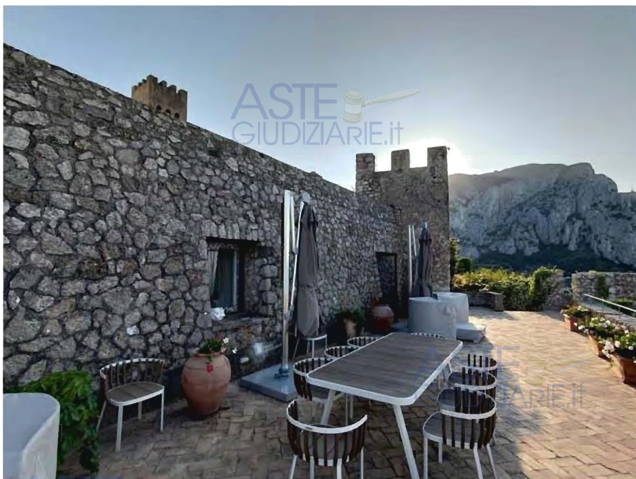
Vista cortina muraria interna
